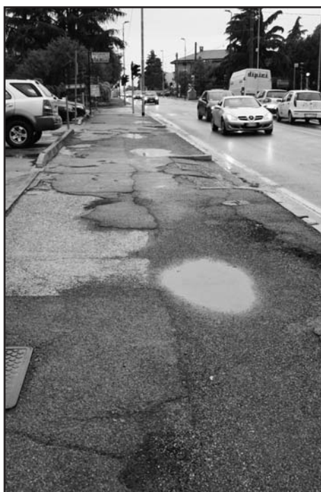
Marciapiedi di via Brescia. (Foto Mor)
