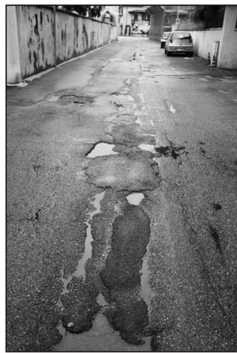
L'attuale situazione di via A. Mazzoldi. (Foto Mor)
